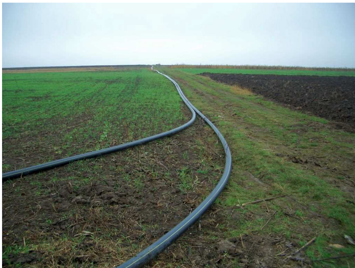
Подготовка на тръбите за полагане - заваряване
